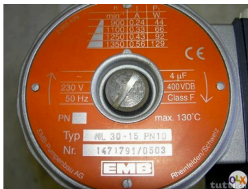
Ersetzte Pumpe: EMB NL 30-15 PN10; Stufe 2 (66 Watt)
